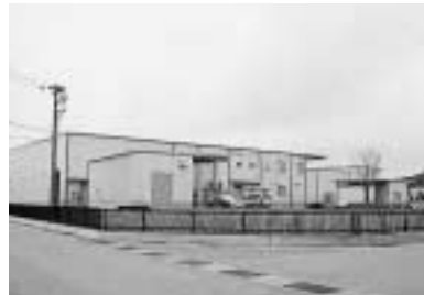
9 / 1 ニッポン高度紙工業南国工場竣工 (十市・高知みなみ流通団地)
