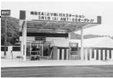
2 / 26 高知自動車道南国サービスエリア上り線ガスステーション開所式 (南国サービスエリア)
