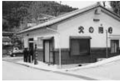
1 / 26 白木谷消防屯所落成 (白木谷)
