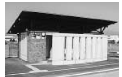
9 / 10 物部川橋北側に公衆ト イレを設置しました。 (物部川堤防)
