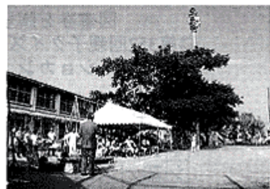
▲8/25 後免野田小学校の夜間照明、バックネット落成 (後免野田小学校)
