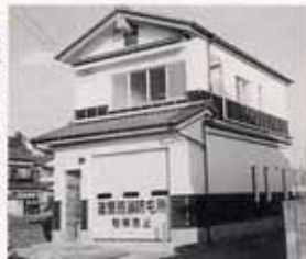
▲篠原消防屯所 新築事業
