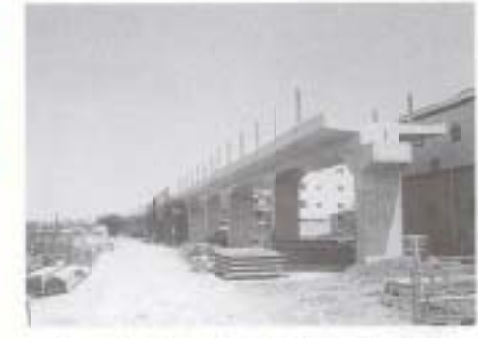
着々と進む 阿佐線建設工事
