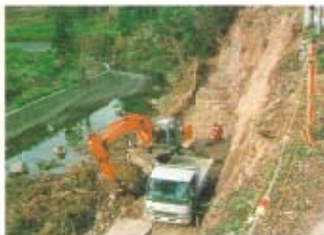
▲着々と進む緊急復旧工事
