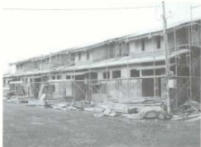
▲工事中の新年(上)改良団地
