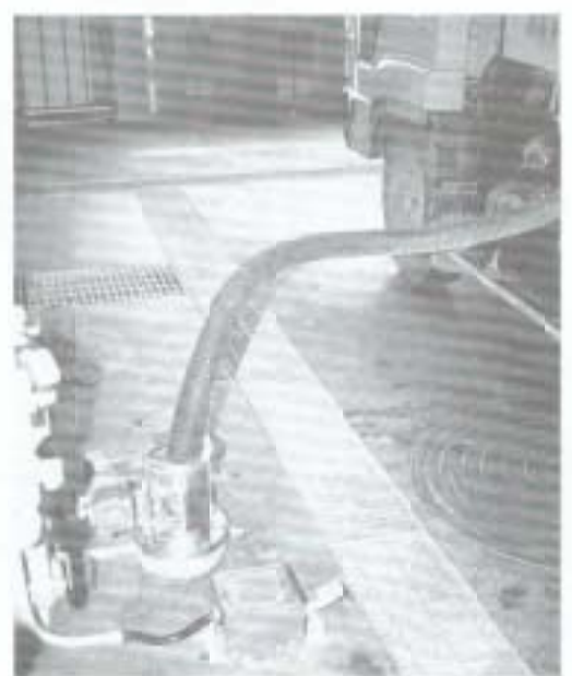
バキュームカーから処理ラインへ投入
