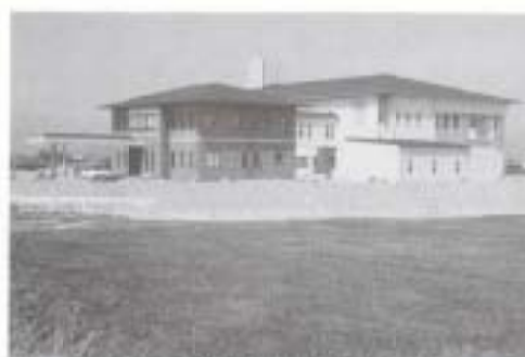
完成直近の新しい尿処理施設
