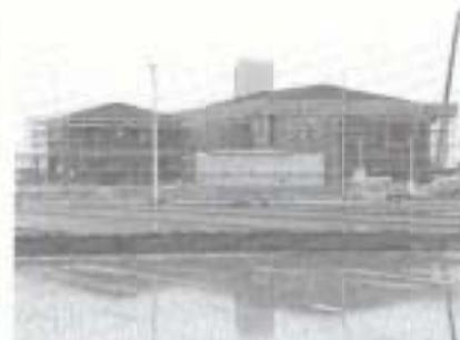
建設の進む新し尿処理場
