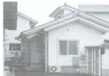
▲昨年9月から工事が進められていた、久礼田小学校の給食棟が完成。潤いのある木を基調とした近代的な給食棟の落成式が6月18日に行われました。
