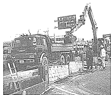
着々と工事が進む浦戸東部流域下水道
