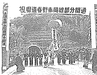
土市・仁井田間開通
