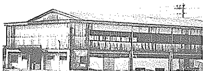
改築される香南中屋内運動場
