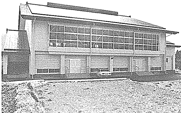
▶ 国府小学校屋内運動場
