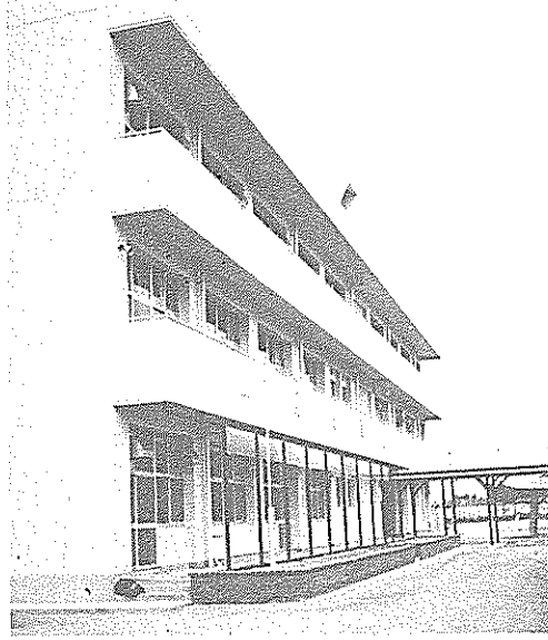
完成した香長中の技術棟
