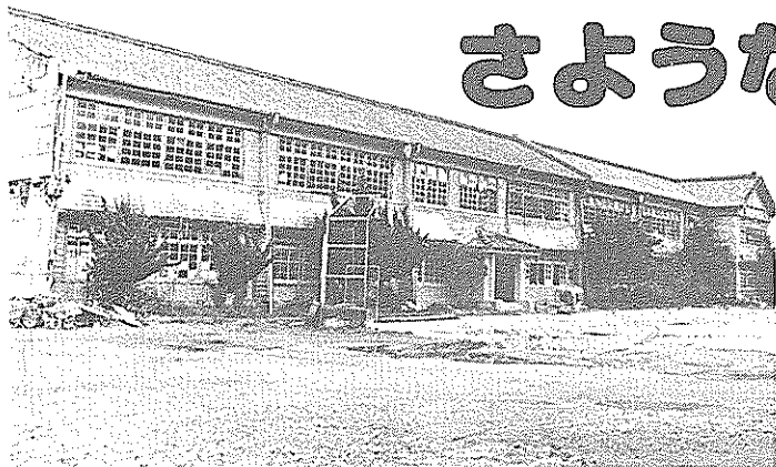
▲老朽化が激しく、取り壊されることになった木造校舎
