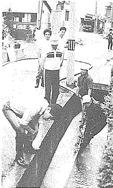
ポンプを使って、排水路を掃除
