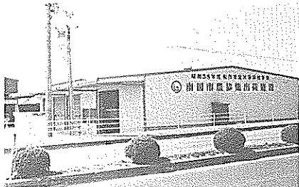
完成した市農協集出荷施設
