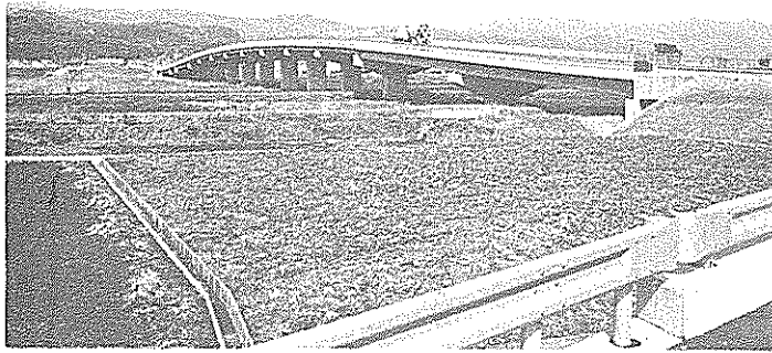
部分開通する高知東道路長崎高架橋付近
