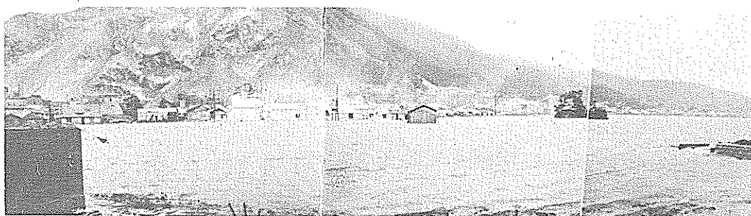
台風10号で下田川がはん濫、浸水した稲生地区(昭45・8・21)
