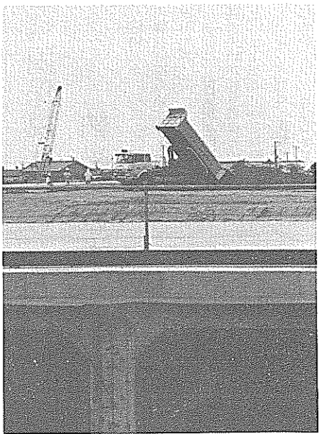
コンクリートの暗渠の上に盛土始まる
