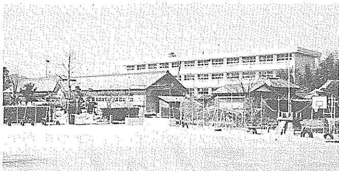
鉄筋コンクリート造3階建て、総事業費2億8,333万円で完成した国府小学校
