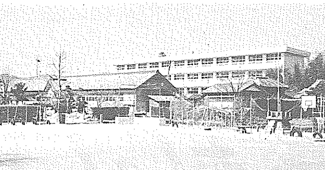
鉄筋コンクリート造3階建て、総事業費2億8,333万円で完成した国府小学校
