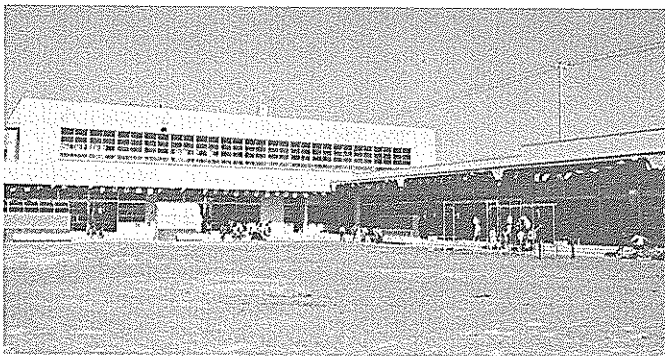
鉄筋コンクリート造2階建て、総事業費1億870万円で完成した後免保育所
