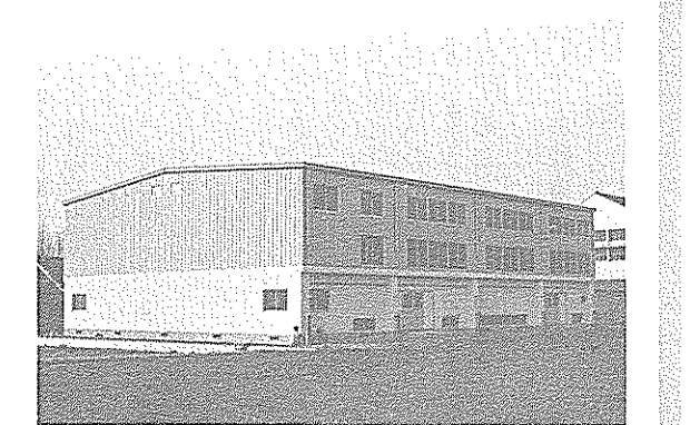
校舎東側に完成した久礼田小体育館。鉄筋コンクリート鉄骨造り、床面積573平方メートル。3月23日には新しい体育館で卒業式が行われました。
