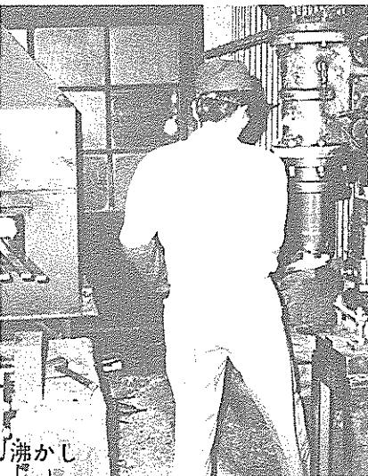
鉄の棒と鋼を炉で熱して、鉄の背を割り鋼を入れる。そして成形する。次に、グライダーで荒研ぎとなる。ついで、手間のかかる仕事だが、これだからこそ切れ味が抜群の打ち刃物ができる。
