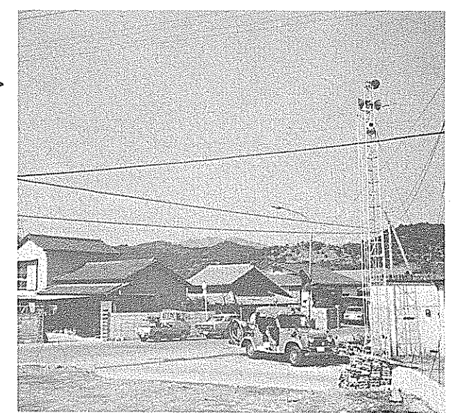
無線遠隔サイレン放送制御装置
