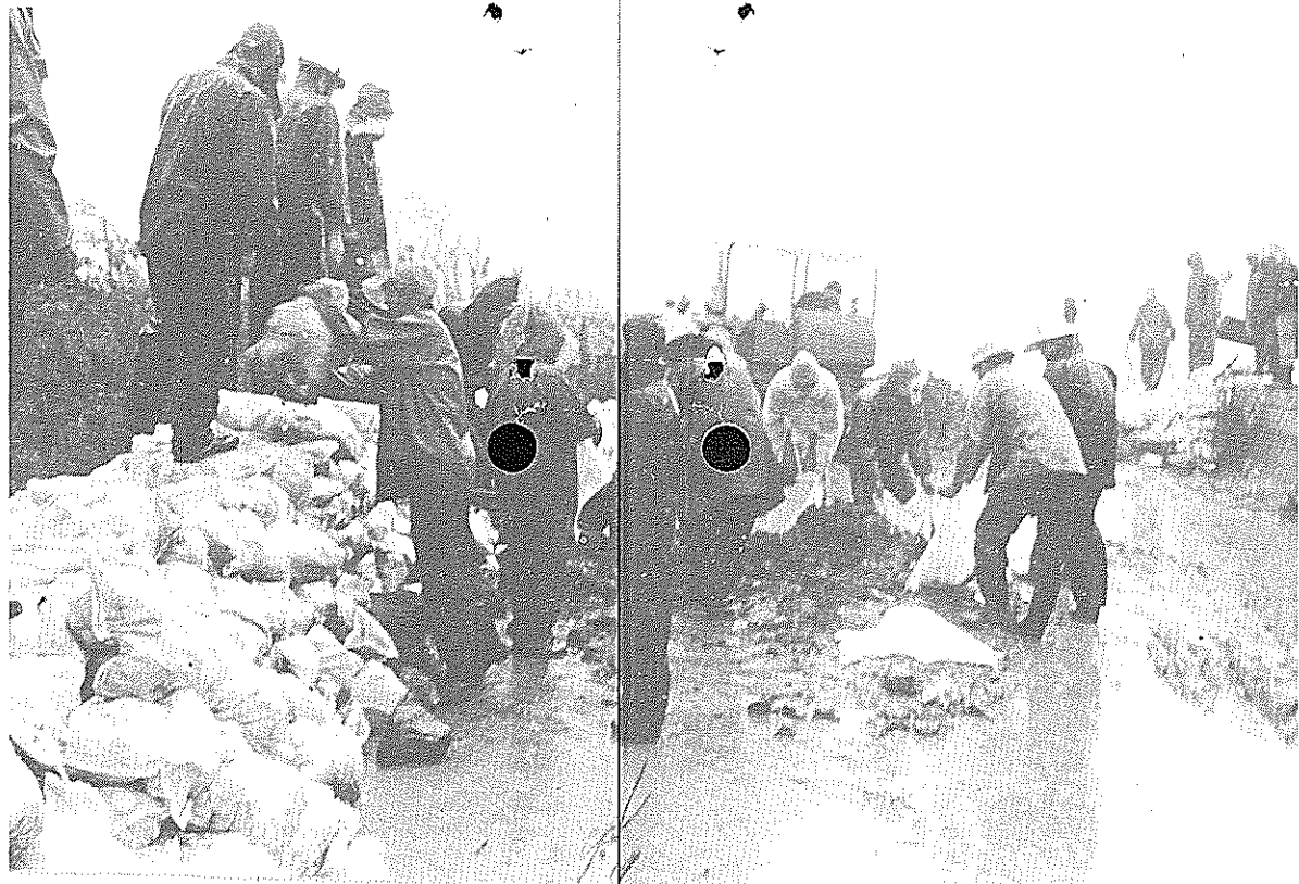
防潮堤を乗り越えて襲ってくる波しぶきを頭からかぶりながら住民ら二百人が懸命の作業(久枝で)
