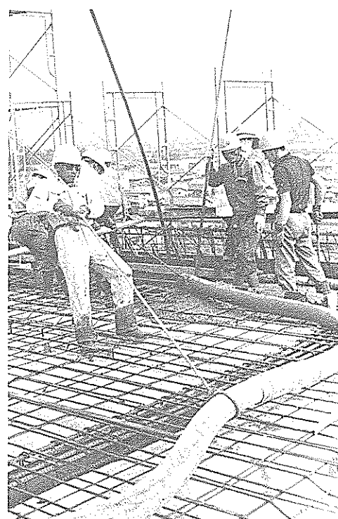
地上から屋上まで、ポンプ車でコンクリートが運ばれ、コンクリート打ちをする。
