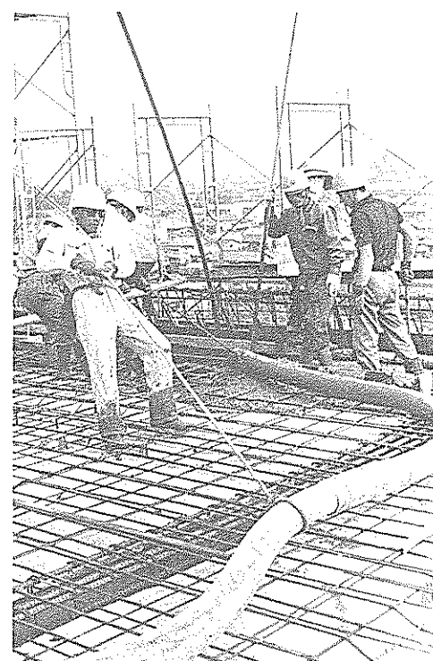
地上から屋上まで、ポンプ車でコンクリートが運ばれ、コンクリート打ちをする。
