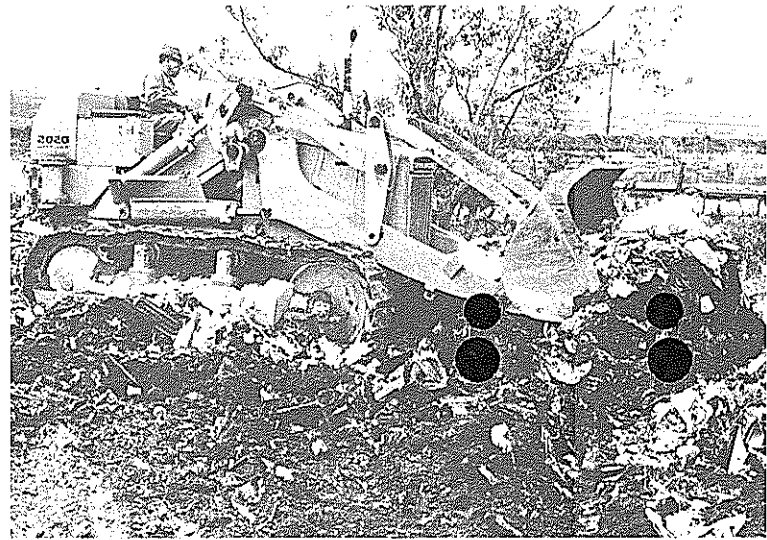
▲いたるところに不法投棄されたビニール類 —大浦で—
