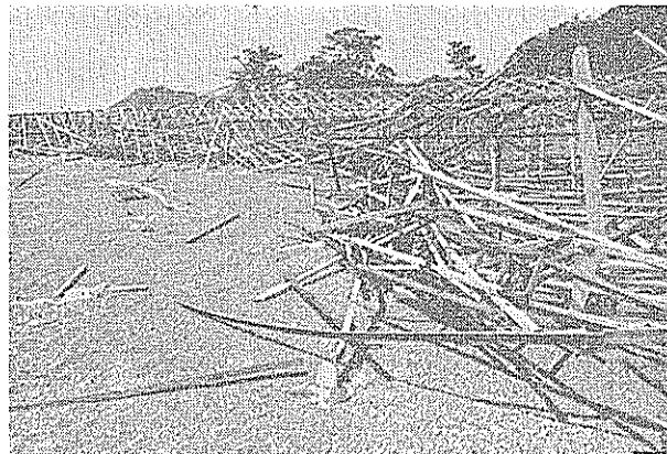
写真(上)＝倒壊し高潮のために打ち寄せられたハウス施設
