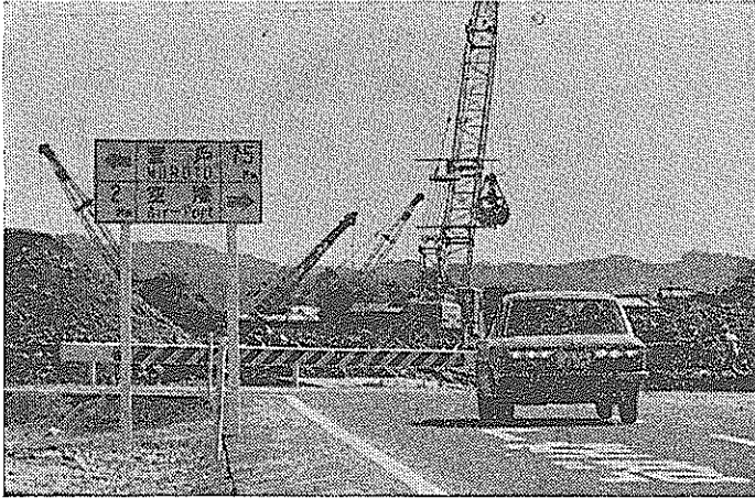
南国バイパスの東端、物部川堤防は切り取られ、橋脚がつくられています。
