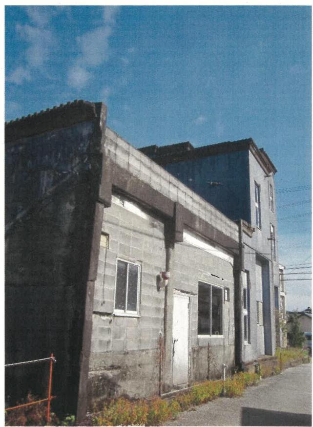
※台風等によりサッシが落下したため、応急措置
