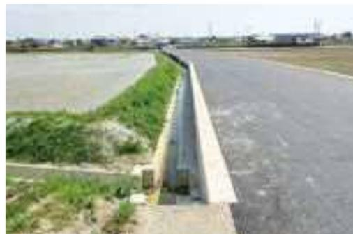
久枝工区の用水路は、給水施設からの水を給水栓により配水する構造となっています。水路は既存分を活用したものと新たに整備したものとで構成されています。（左：給水施設、右：整備後水路）
