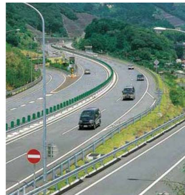
高知自動車道
