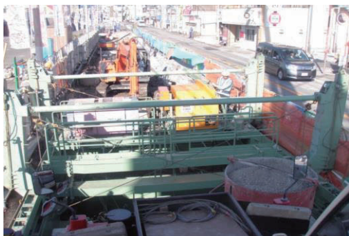
雨水対策工事
