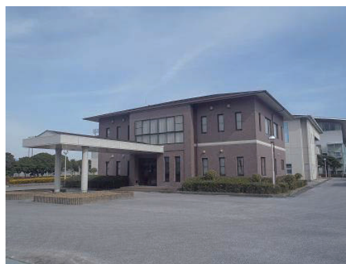
南国市環境センター（し尿処理場）
