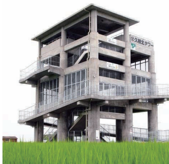
津波避難施設久枝北タワー
