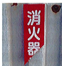
× 標識の破損
