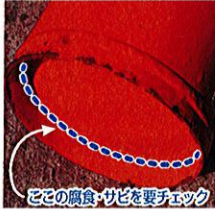
× 底部の腐食
