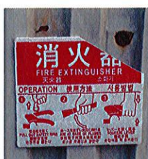
× 標識の破損
