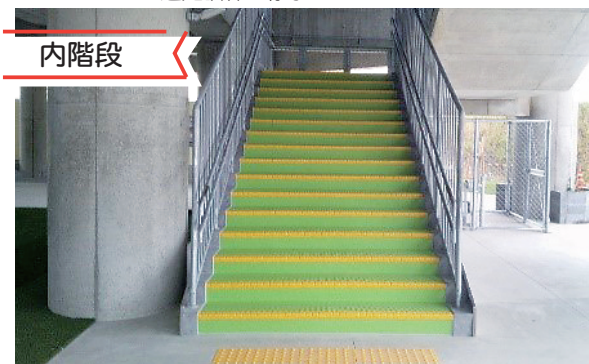
横幅1.8メートルのタワー内部階段
