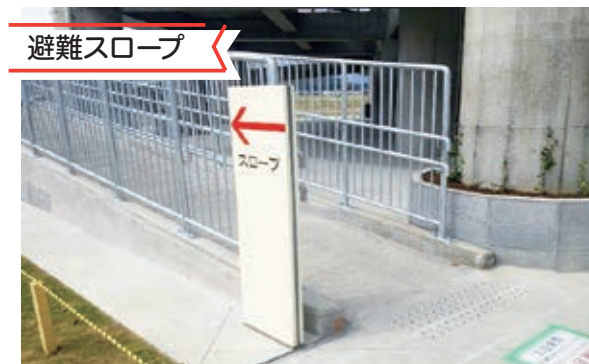
車いすなど、階段利用が困難な避難者用にスロープも設置
