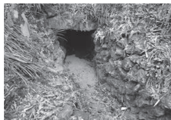
奈路の隧道(奈路)
