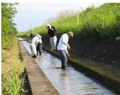
水路補修（藻除去）
