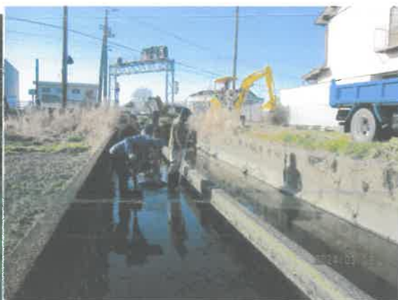
水路の泥上げ
