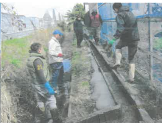
漏水水路の補修
