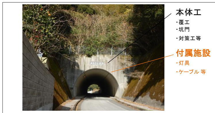
図 2.1 トンネル構造
