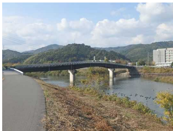
延長の長い橋の事例
