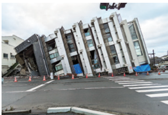
倒れた7階建て五島屋ビル
