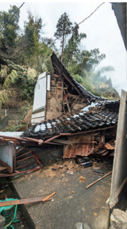
土砂崩れによる蔵と家屋の倒壊
