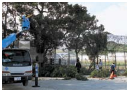
愛校作業 高所作業車で枝切り
