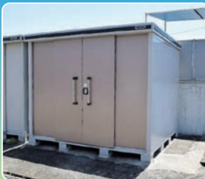
大湊小学校 [倉庫]
