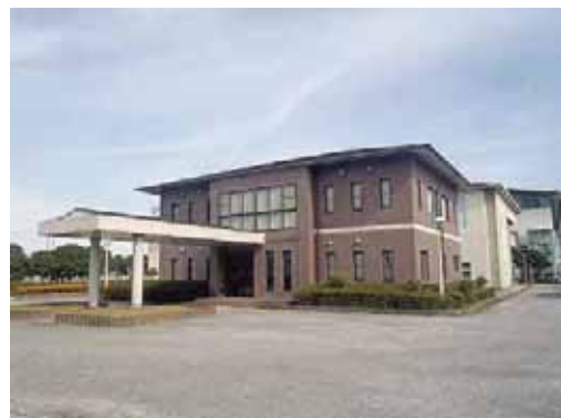
南国市環境センター（し尿処理場）
