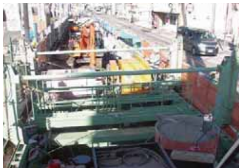
雨水対策工事
